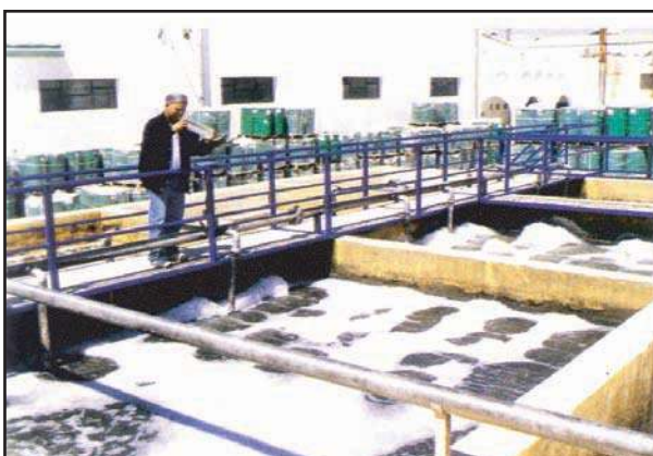
4- Une station d'épuration élimine environ 80% de la matière organique
