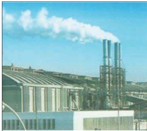
8. Usine de traitement de phosphate
