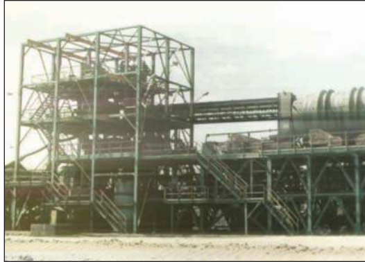
4. Unité de lavage du phosphate à Redeyef
