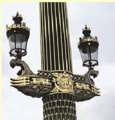
Protection anticorrosion par un système glycérophthalique, décor avec une dorure à la mixtion
