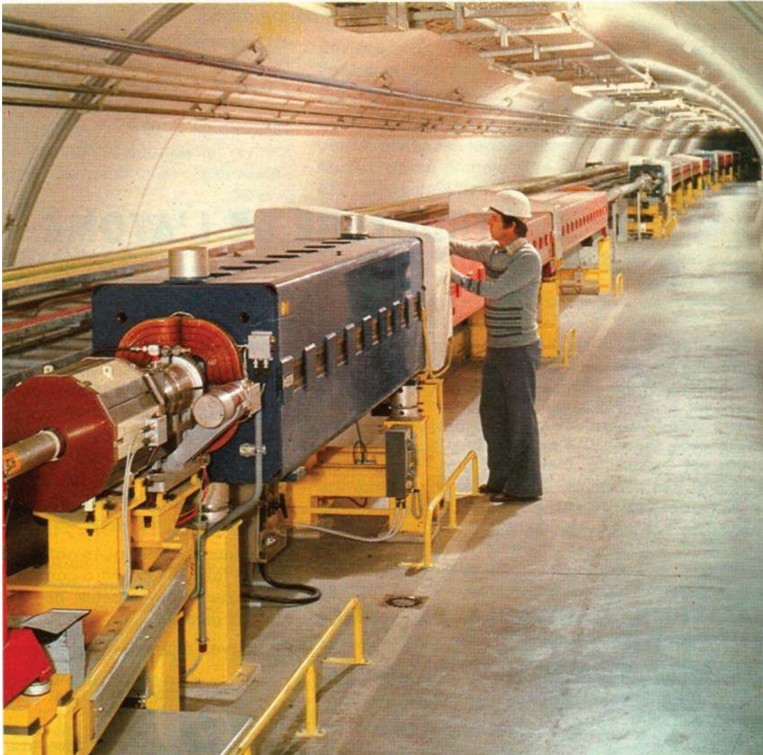
Accélérateur de particules
