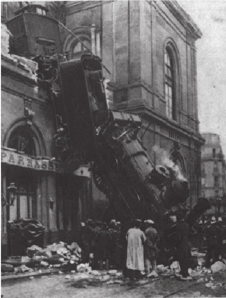
Photo.1 : les méfaits de l'énergie cinétique.
