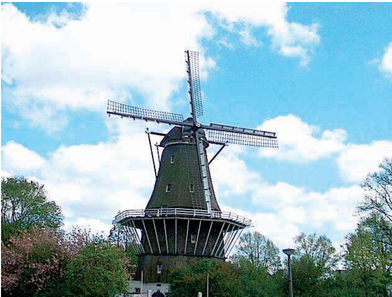
Photo.1 : l'effet du vent sur les pales se manifeste par un couple de forces qui fait tourner l'hélice.
