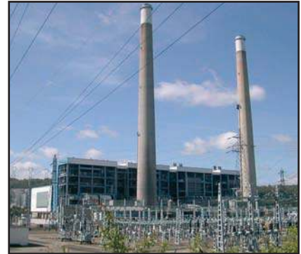
Fig .20 Centrale thermique
